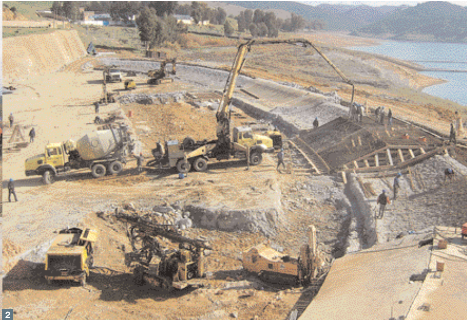
1. Robert Noël, directeur des travaux, et Jules Delbos, conducteur de travaux. 2. En janvier, le chantier en était à la préparation du seuil, long de 185 m, pour la pose des 20 hausses fusibles.
